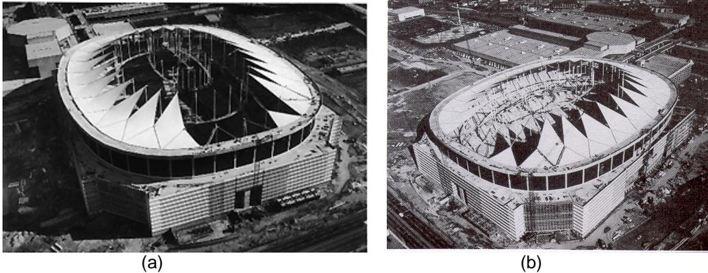
Figura 4 – Fotos da montagem da estrutura da cobertura do Georgia Dome (Terry, 1994)
